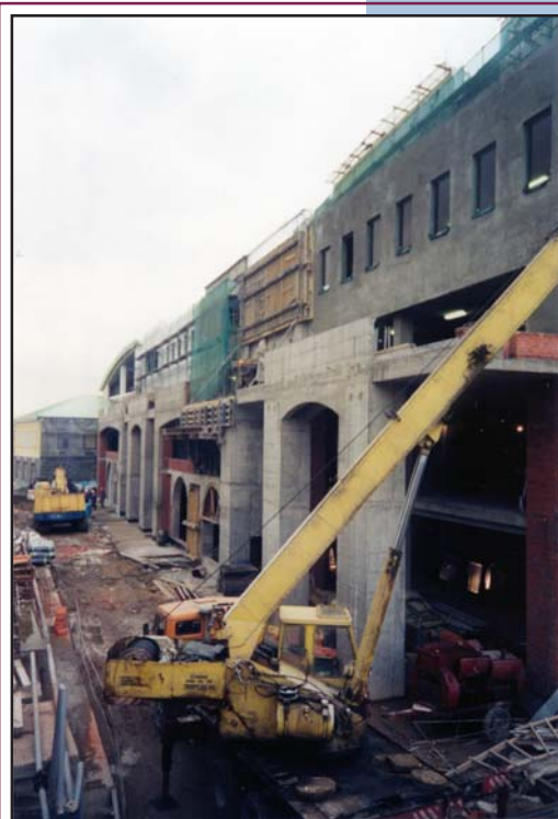
Рис. 4. Многофункциональный комплекс «Царев сад» в Москве. Возведение фасадных стен Строения 1.
