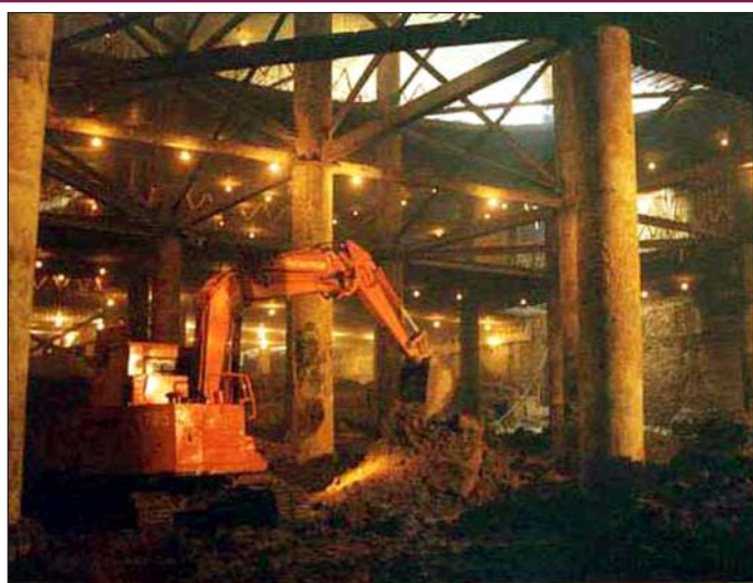
Рис. 3. Многофункциональный комплекс «Царев сад» в Москве. Временная металлическая крепь проемов в перекрытиях подземной части Строения 1 на месте въездной рампы.
