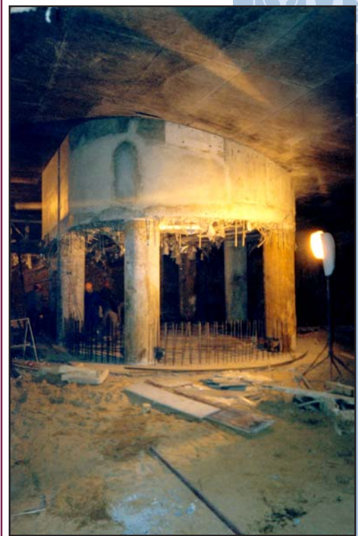
Рис. 9. Многофункциональный комплекс «Арбат-Центр» в Москве. Вид на «вывешенные» на буровых колоннах конструкции центрального ядра рампы на -3-м этаже на западной половине автостоянки накануне возведения рампы на -4-м этаже.
