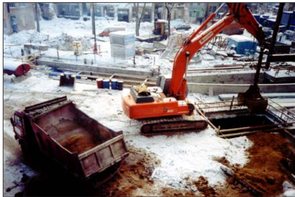
Рис. 11. Многофункциональный комплекс «Арбат-Центр» в Москве. Выдача грунта на поверхность для погрузки в автосамосвалы грейферным экскаватором «Hitachi EX300-5» через временный монтажный проем во время экскавации 2-го яруса котлована.
