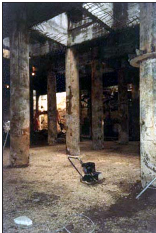
Рис. 5. Многофункциональный комплекс «Царев сад» в Москве. «Вывеска» лифтовых и вентиляционных шахт ядра жесткости надземной 8-этажной части Строения 3 на буровых колоннах.
