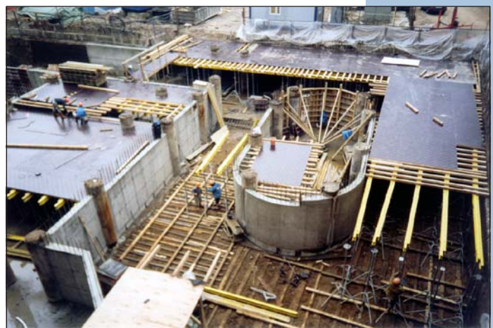
Рис. 8. Многофункциональный комплекс «Арбат-Центр» в Москве. Вид на рампу на -1-м этаже на западной половине автостоянки после возведения стен центрального ядра и внешних противопожарных стен рампы до возведения покрытия.
