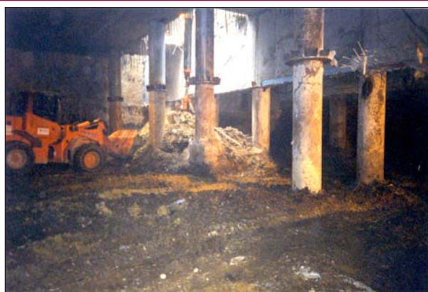
Рис. 15. Многофункциональный комплекс «Арбат-Центр» в Москве. Экскавация грунта на 4-м ярусе котлована в зоне рампы на восточной половине автостоянки.
