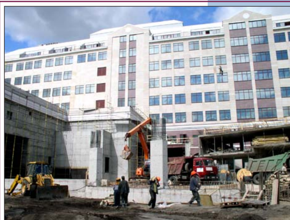
Рис. 18. Многофункциональный комплекс «Арбат-Центр» в Москве. Завершение строительства пристроя к главному корпусу. Возведение конструкций корпуса третьей очереди строительства над восточной половиной подземной автостоянки во время экскавации грунта на 5-м ярусе котлована.
