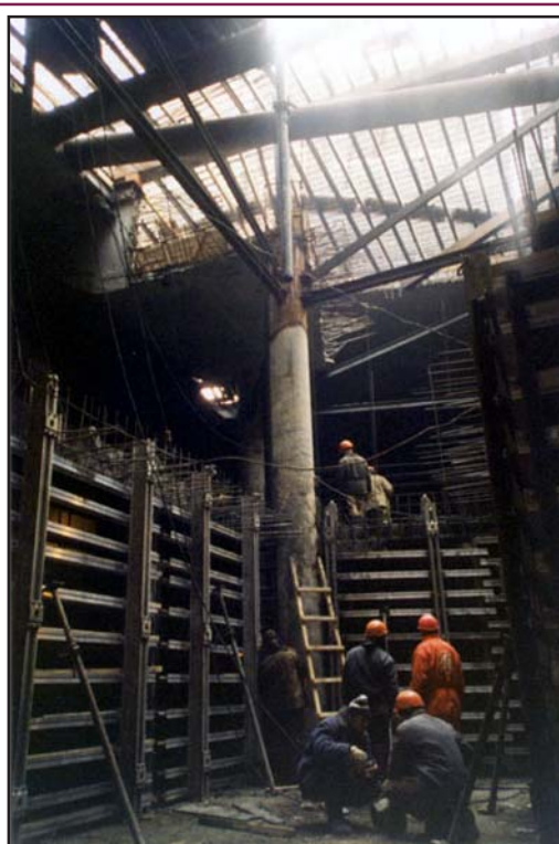
Рис. 1. Возведение лифтовых шахт и лестничных клеток на строительстве фондохранилища музея А.С. Пушкина в Москве.
