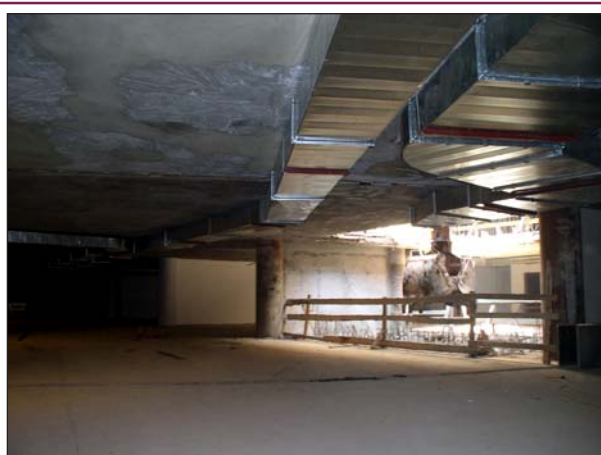
Рис. 17. Многофункциональный комплекс «Арбат-Центр» в Москве. Монтаж постоянных систем вентиляции и пожаротушения на -2-м этаже во время экскавации грунта на 5-м ярусе котлована.
