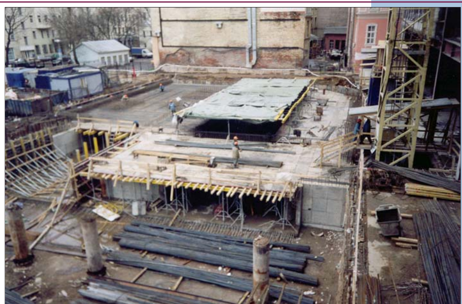
Рис. 6. Возведение первой половины покрытия. Опалубочные и арматурные работы.
