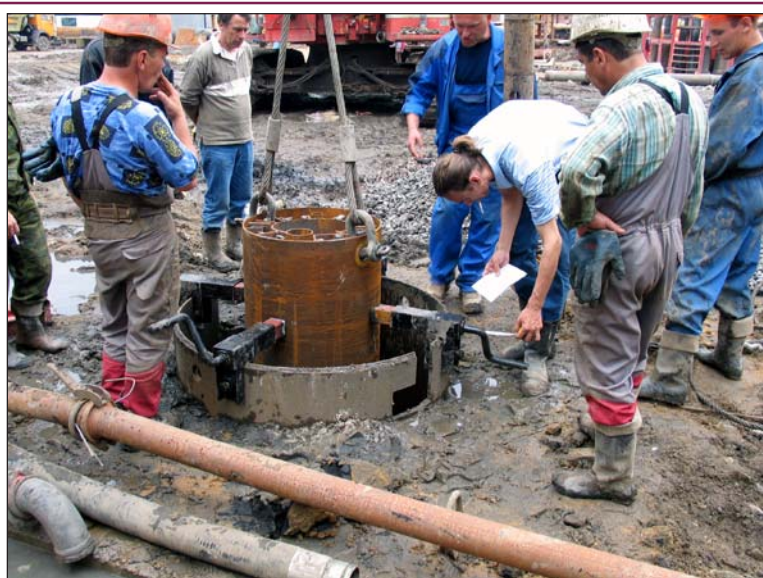
Рис. 10. Центрирование арматурного каркаса колонны буровой колонны стандартной длины.
