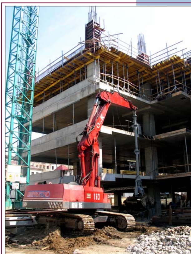
Рис. 18. Начало экскавации грунта на уровне В2 под защитой перекрытия на отм. -4,700 м.
