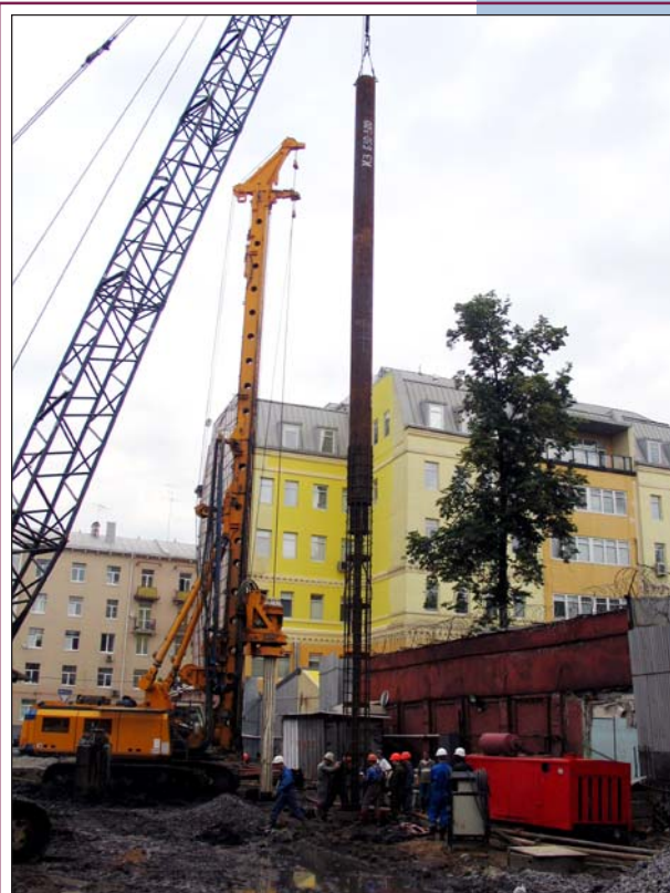
Рис. 8. Монтаж в скважину арматурного каркаса буровой колонны стандартной длины.
