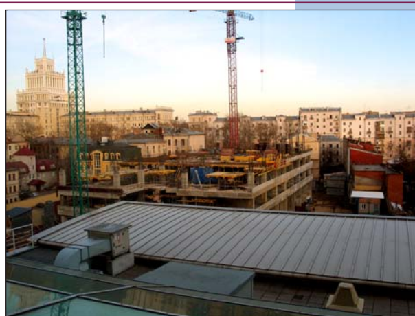
Рис. 16. Вид на строящееся способом «top & down» здание «Дукат Плейс III» из коридора здания «Дукат Плейс II».
