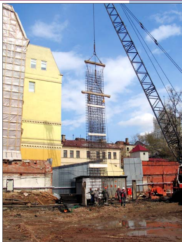
Рис. 4. Установка арматурного каркаса при возведении панели траншейной стены.
