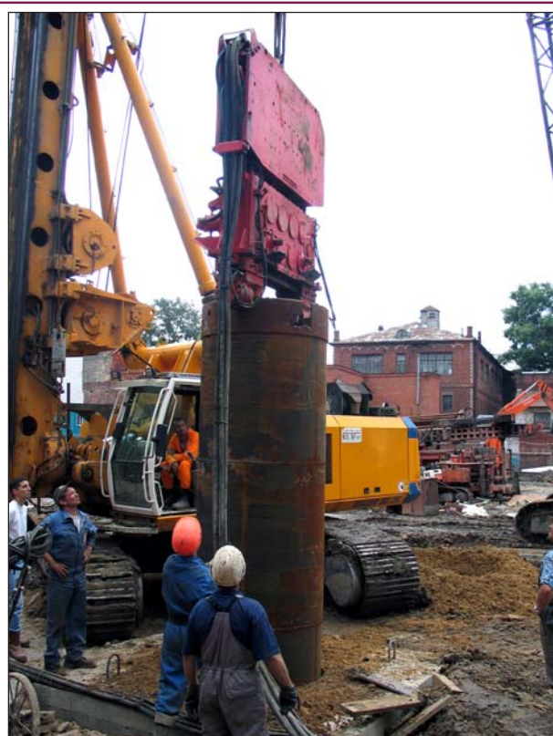
Рис. 7. Установка инвентарного патрубка вибропогружением через отверстие в форшахте.
