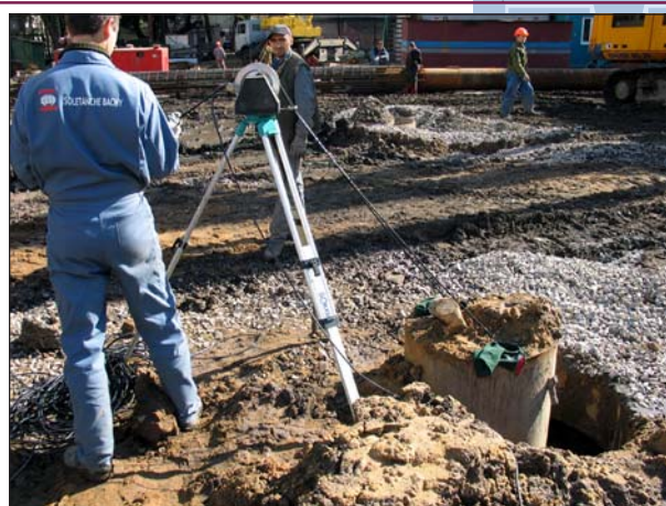
Рис. 12. Ультразвуковой контроль качества бетонирования буровой колонны.
