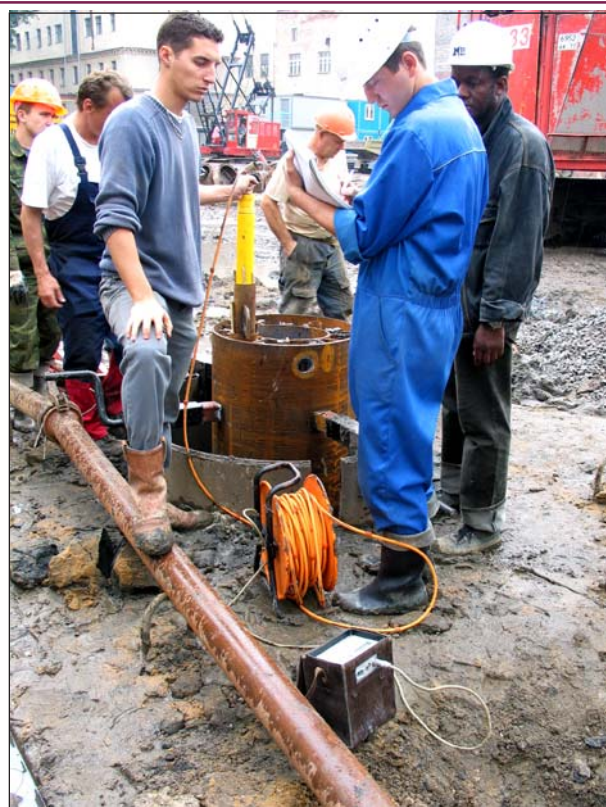
Рис. 11. Инклинометрический контроль вертикальности установки арматурного каркаса буровой колонны через закладную трубу.
