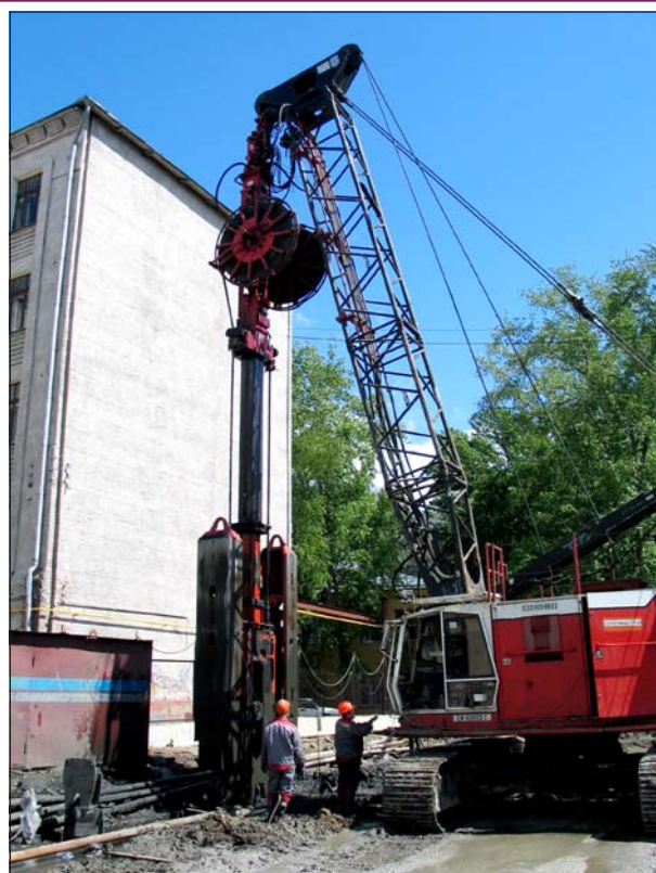
Рис. 3. Разработка траншеи вблизи существующего здания с использованием гидравлического грейферного оборудования.
