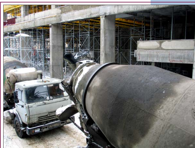
Рис. 14. Доставка бетонной смеси на строительную площадку автобетоносмесителями с заездом на перекрытие на отм. 0,000 м после завершения экскавации грунта под ним на уровне В1.
