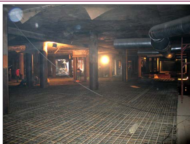
Рис. 17. Возведение перекрытия на отм. -4,700 м безопалубочным методом.
