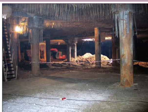
Рис. 15. Завершение экскавации грунта на уровне В1 под защитой перекрытия на отм. 0,000 м.
