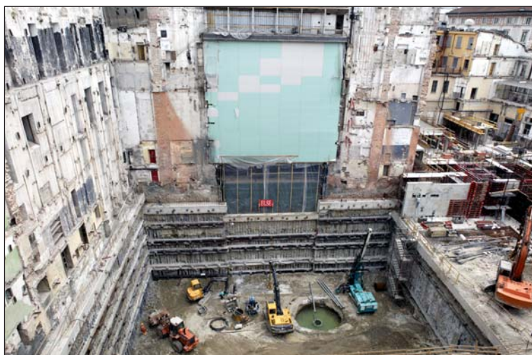
Рис. 8. Вид на котлован строящейся новой сцены.
