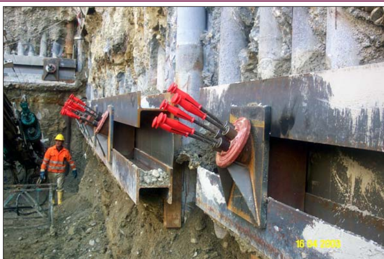
Рис. 10. Фрагмент анкерного крепления
