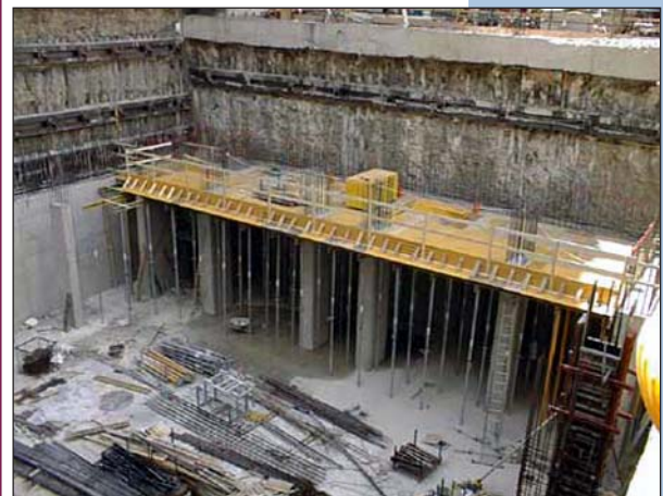
Рис. 6. Возведение конструкций новой сцены.
