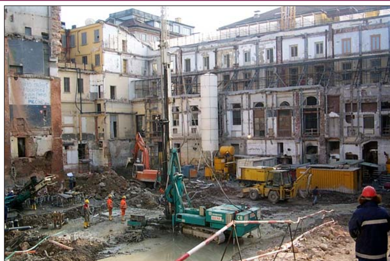
Рис. 14. Выполнение грунтоцементных колонн по технологии «jet-grouting».
