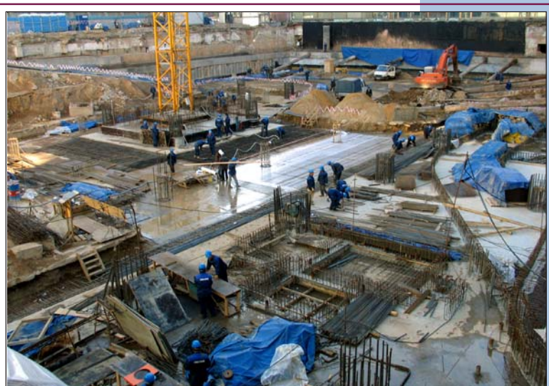
Рис. 9. Основание башенного крана на перекрытии над 3-м подземным этажом. Возведение захваток перекрытия безопалубочным способом.
