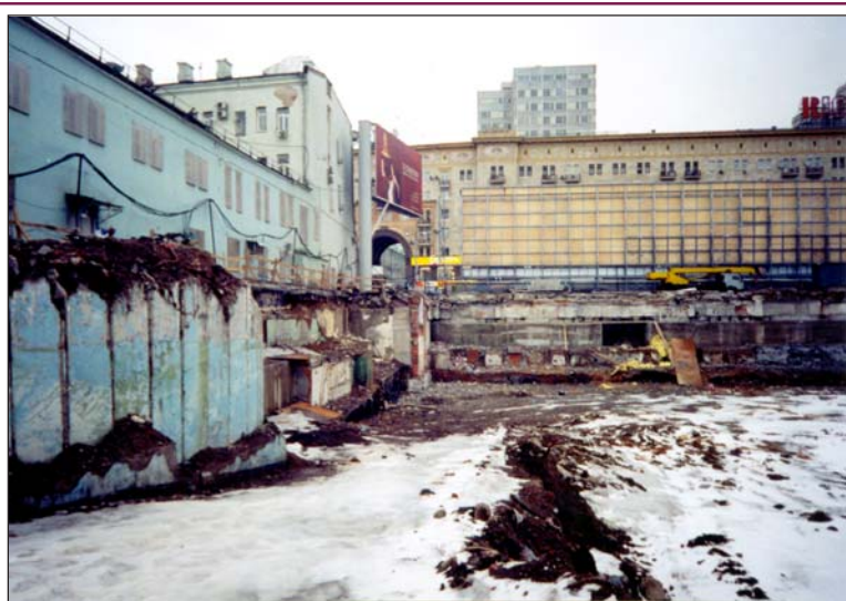
Рис. 1. Февраль 2003 г. Вид на котлован, оставленный после сноса гостиницы «Интурист».
