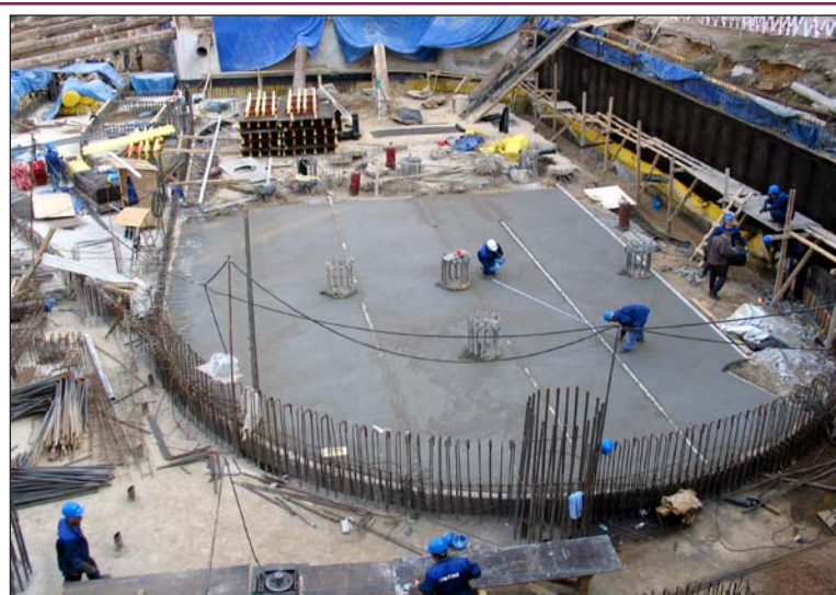
Рис. 8. Устройство выравнивающей стяжки из цементно-песчаного раствора на подготовленном грунтовом основании перед возведением захватки перекрытия над 3-м подземным этажом в зоне ramпы.
