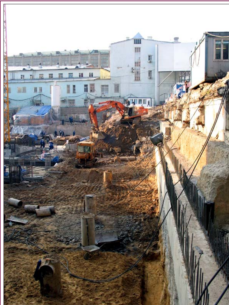
Рис. 10. Ликвидация временного съезда в открытый котлован после монтажа башенного крана.
