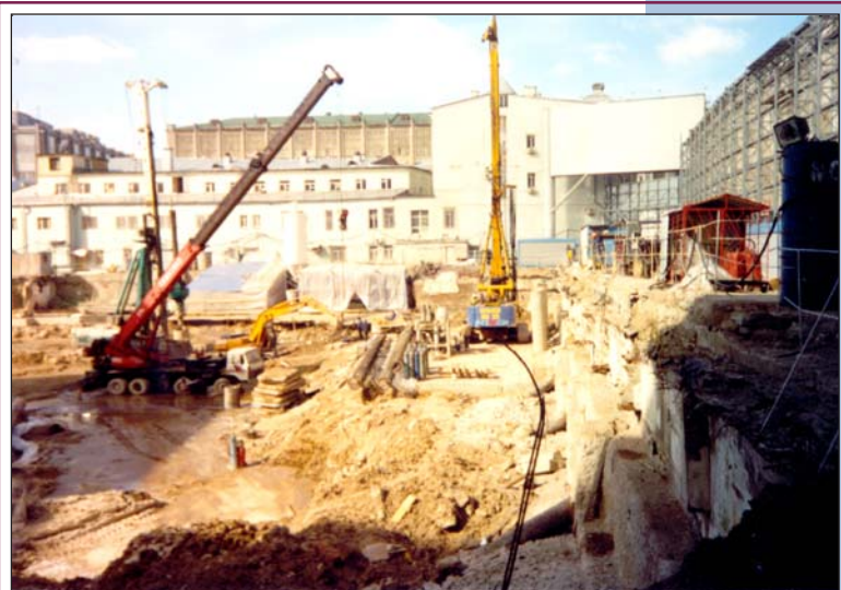
Рис. 5. Возведение стены из буросекущихся свай вдоль коллектора мелкого заложения с гребня пригрузочной бермы. Опережающая разборка старых конструкций и устройство форшахты под защитой временной металлической подкосной крепи.
