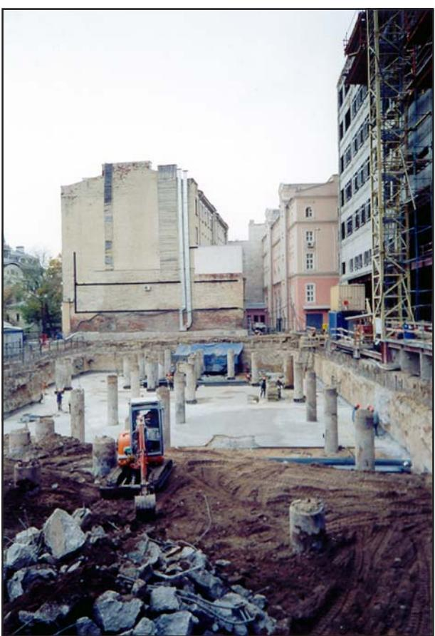
**Рис. 5.** Возвведение первой половины перекрытия над 2-м этажом безопалубочным способом.
