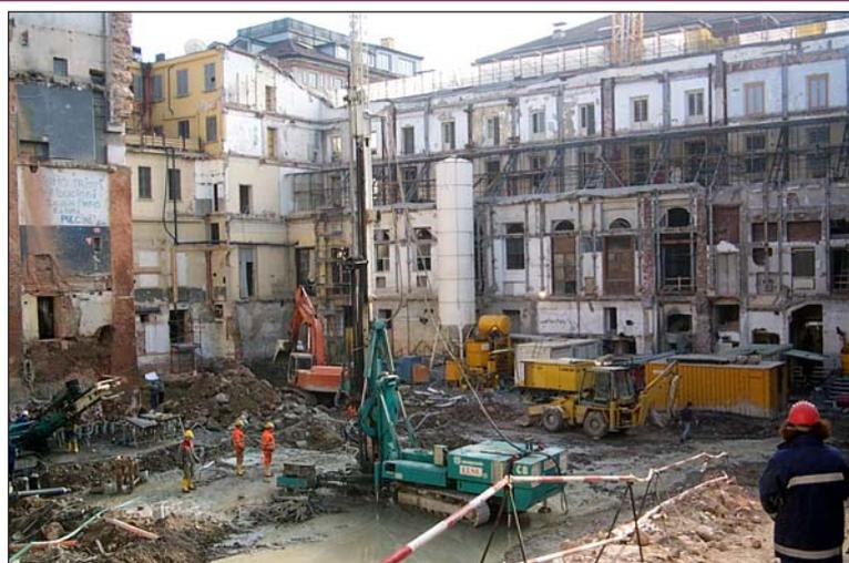
Рис. 14. Выполнение грунтоцементных колонн по технологии «jet-grouting».
