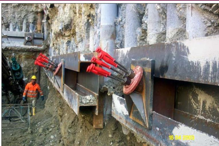
Рис. 10. Фрагмент анкерного крепления
