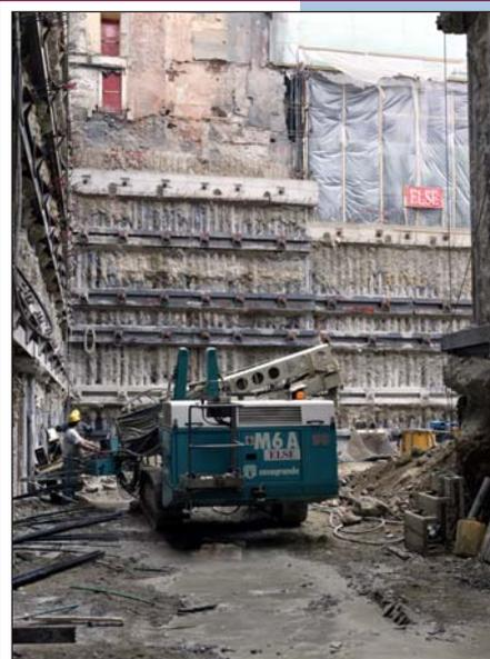
Рис. 11. Устройство анкерного крепления.
