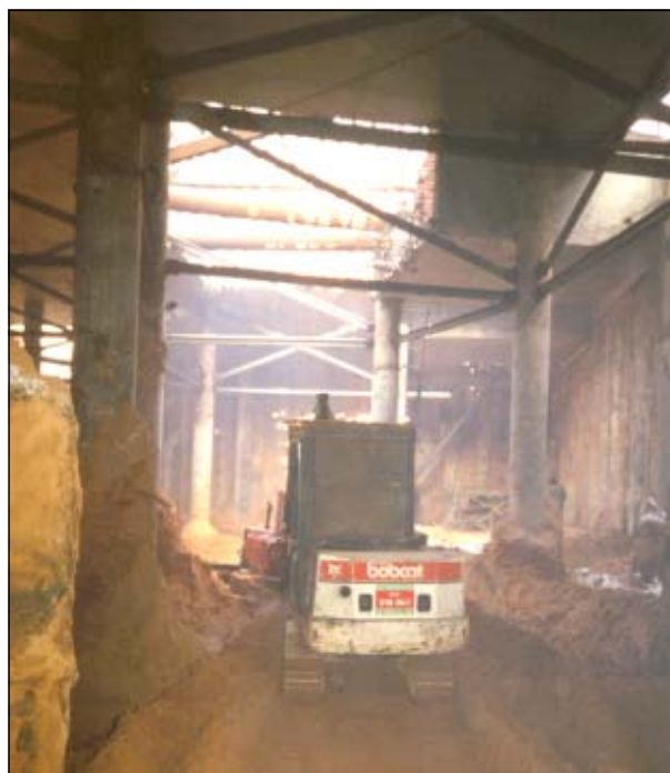
Рис. 4. Разработка грунта под защитой перекрытия
