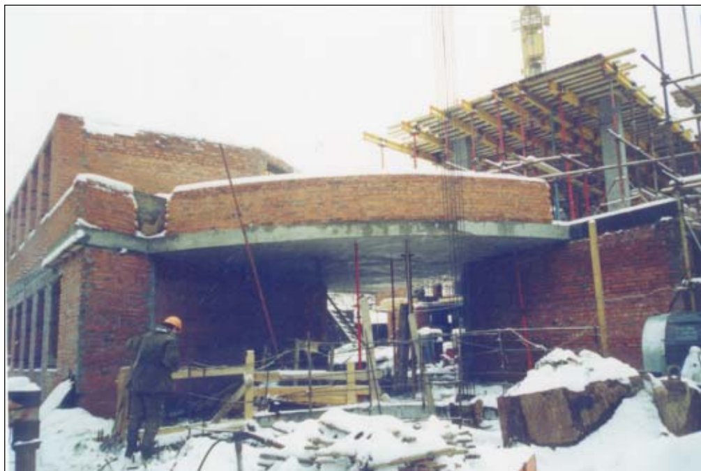
Рис. 6. Совмещение работ по строительству подземной и наземной частей фондохранилища
