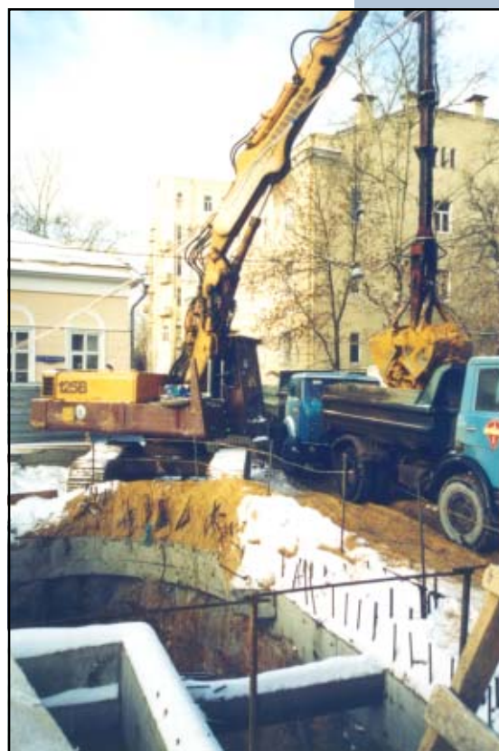
Рис. 5. Выдача грунта через монтажный проем и погрузка его в автосамосвалы
