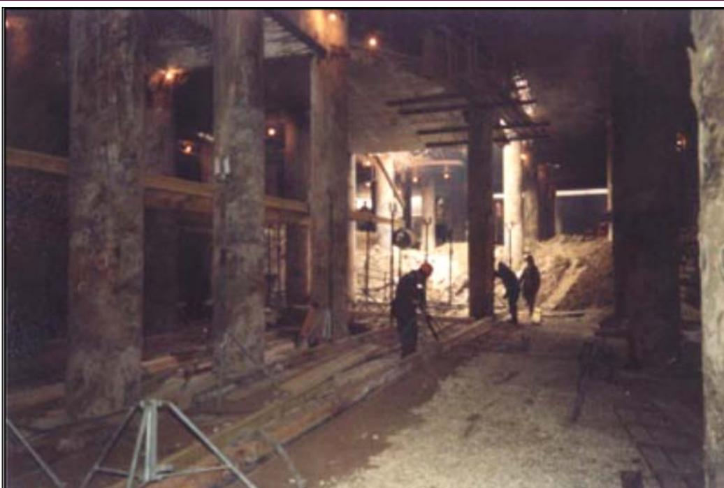
**Рис. 10.** Строение 3 Многофункционального комплекса «Царев сад» в Москве. Возведение перекрытия над -2-м этажом.
