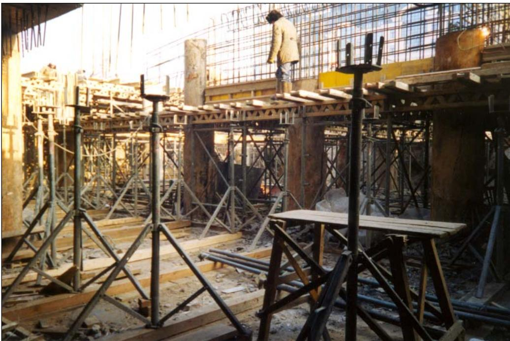
**Рис. 7.** Строение 1 Многофункционального комплекса «Царев сад» в Москве. Возвведение стен усиления лифтовых шахт центрального ядра.
