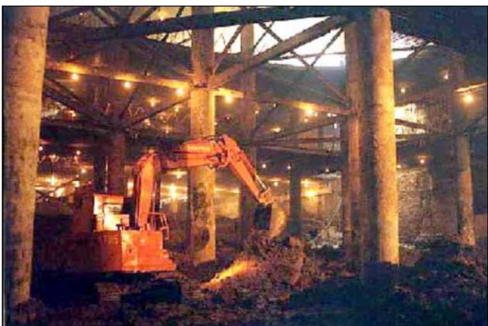
**Рис. 13.** Строение 1 Многофункционального комплекса «Царев сад» в Москве. Разработка грунта малогабаритным экскаватором «Hitachi» EX60 на 3-м ярусе котлована в зоне проемов под въездную рампу под защитой временной металлической крепи.
