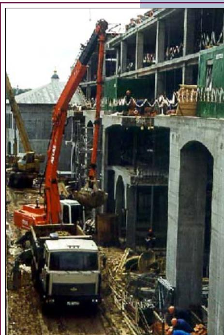
**Рис. 14.** Строение 1 Многофункционального комплекса «Царев сад» в Москве. Выдача разработанного грунта из-под перекрытий через временный монтажный проем и его погрузка в автомобиль-самосвал грейфером на экскаваторе «ATLAS» 1704.
