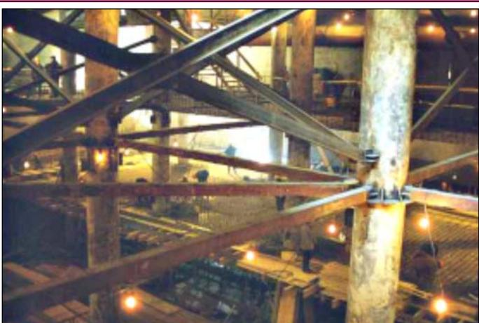
**Рис. 15.** Строение 1 Многофункционального комплекса «Царев сад» в Москве. Возвведение перекрытия над -3-м этажом в зоне проемов под въездную рампу.
