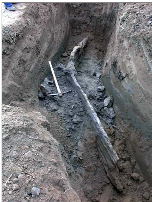
Рис. 28. Опытная панель в грунте, выполненная ламинарной струйной цементацией.
