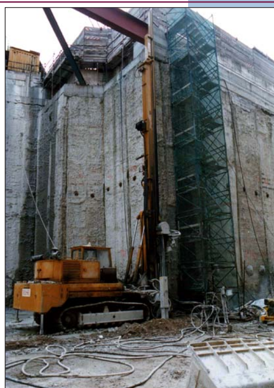
Рис. 20. Строительство подземной автостоянки на Via Puccini в Милане. Устройство горизонтальной противofильтрационной завесы с промежуточной отметки дна котлована (-18,0 м).
