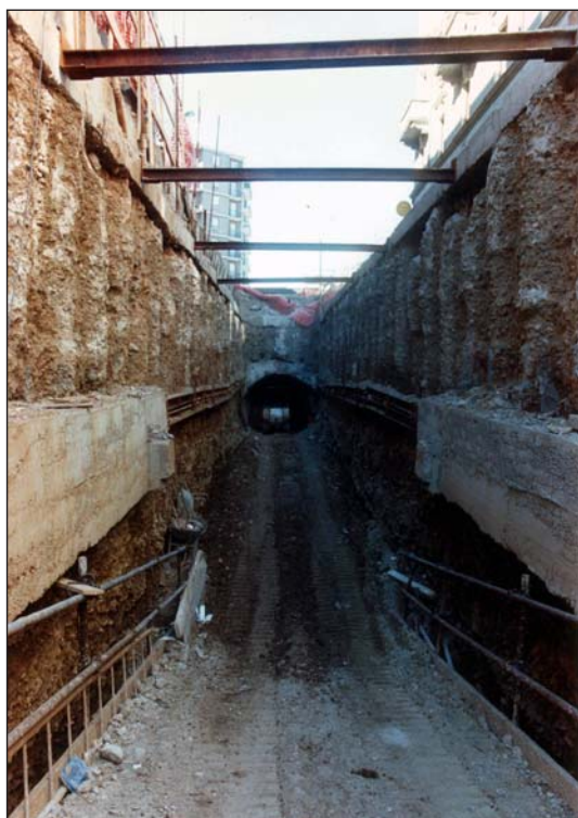
Рис. 15. Строительство коллектора открытым способом в Милане в коммуне «San Giovanni».
