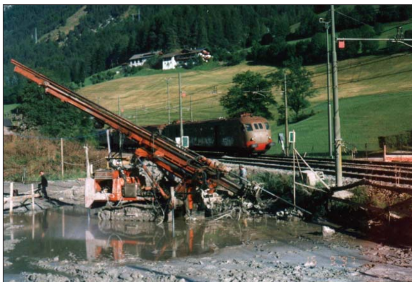
Рис. 12. Струйная цементация грунтов на строительстве двухполосного автодорожного тоннеля под насыпью железной дороги, связывающей города Verona и Brennero, без прекращения движения поездов.
