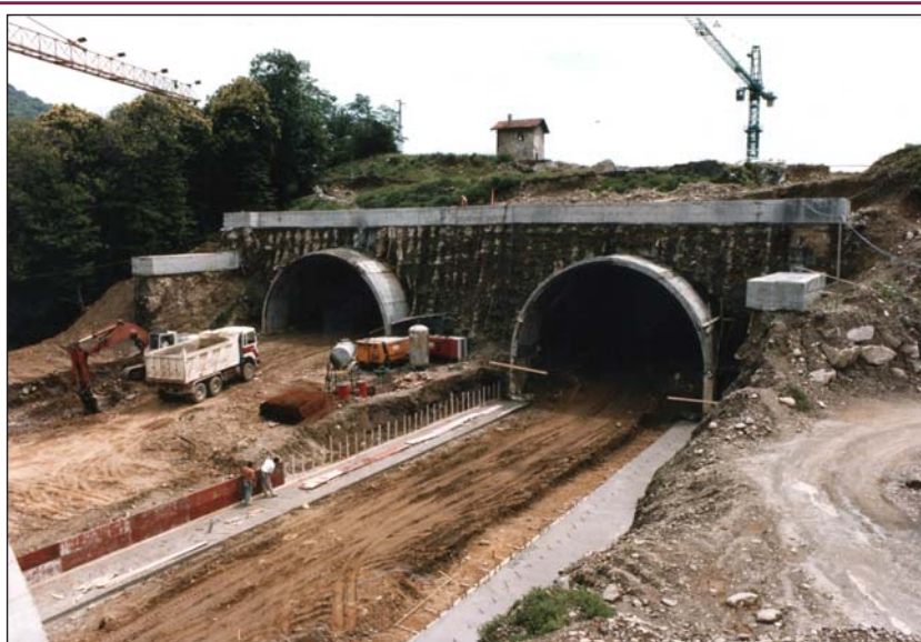
Рис. 10. Вид на северный портал, укрепленный грунтоцементными колоннами, во время строительства автомобильных тоннелей «Malenchini».
