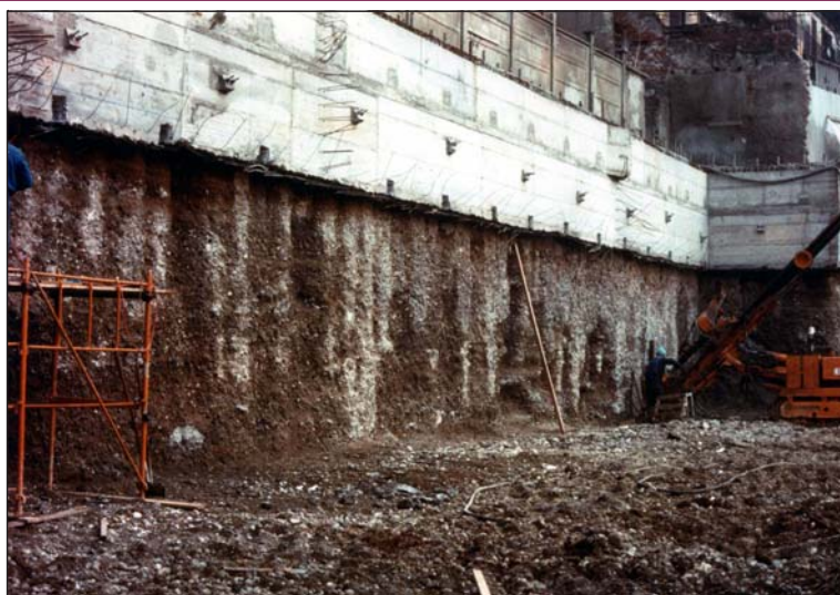
Рис. 17. Вид на ограждение котлована из секущихся грунтоцементных свай-колонн на строительстве нулевого цикла нового офисного здания на Via Valenza в Милане во время устройства второго яруса анкерной крепи.
