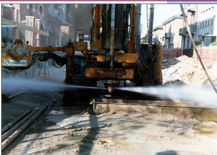
Рис. 14. Строительство коллектора открытым способом в Милане в коммуне «San Giovanni». Промывка струйного монитора.
