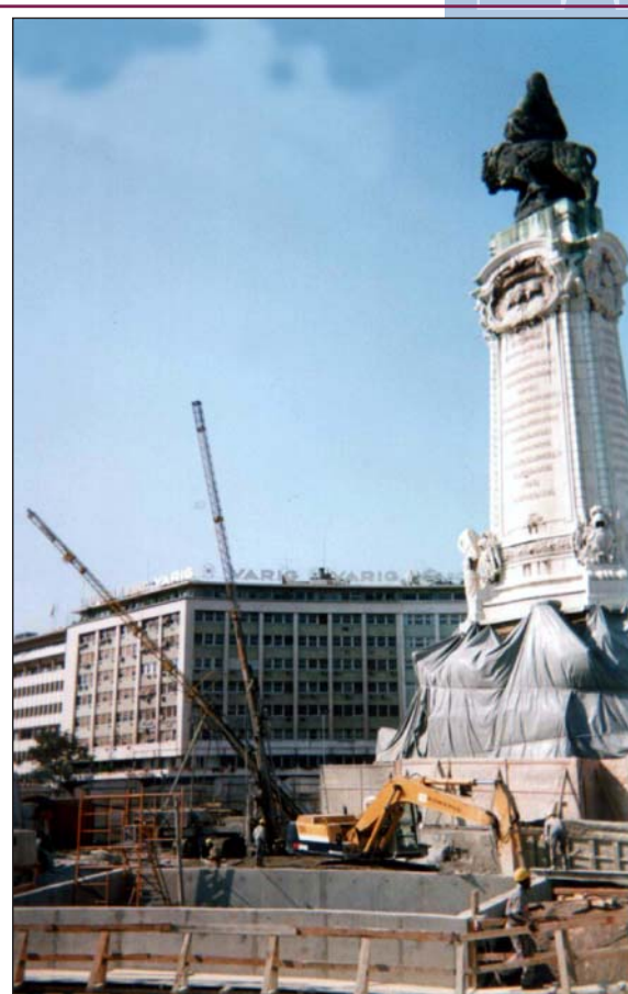
Рис. 7. Струйная цементация грунтов на строительстве основного и сервисного тоннелей метрополитена под монументом на площади Marquis de Pombal в г. Лиссабоне. Производство работ.
