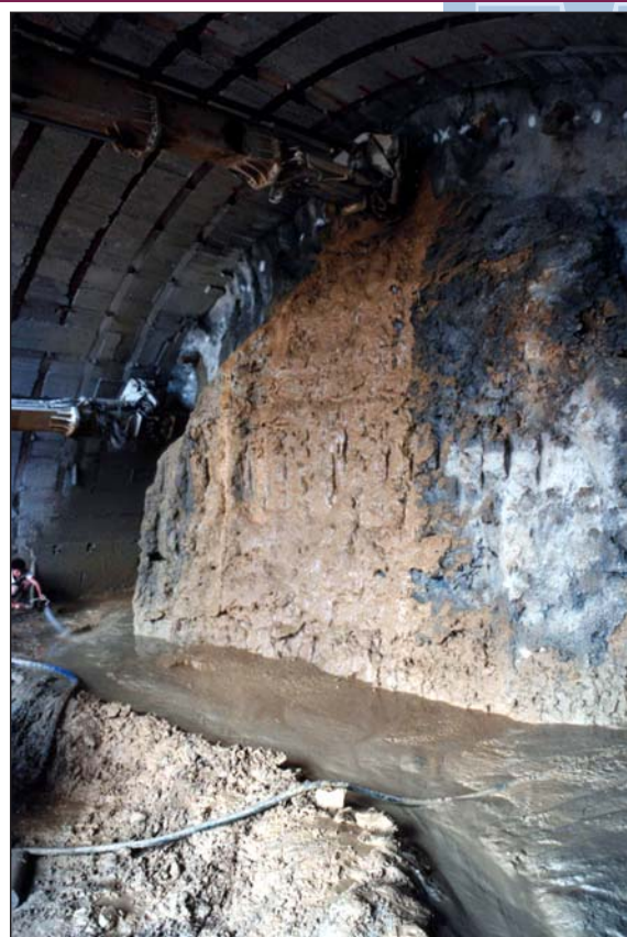
Рис. 9. Выполнение грунтоцементных колонн зонтика опережающей крепи во время строительства автомобильного тоннеля «Malenchini» на автострате Livorno-Civitavecchia.
