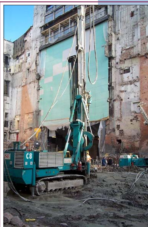
Рис. 25. Струйная цементация грунтов при строительстве подземной части новой сцены реконструируемого театра «Ла Скала» в Милане (на заднем плане сохраняемая часть здания театра – зрительный зал).
