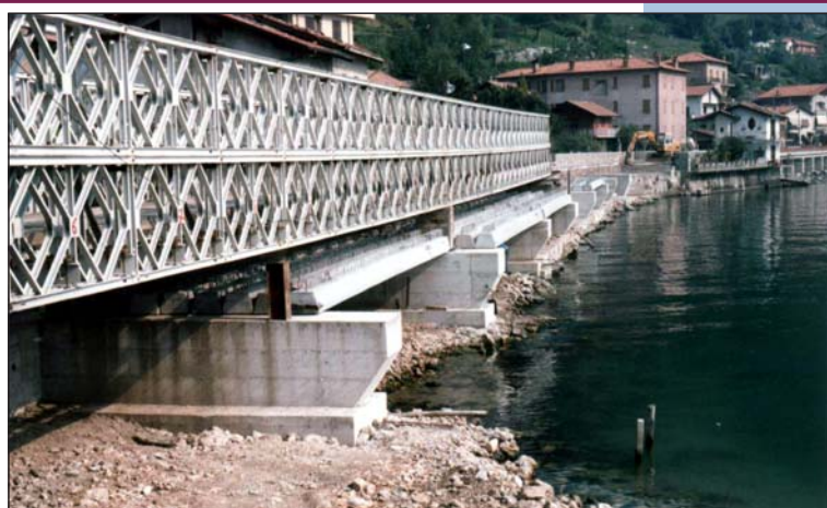
Рис. 23. Вид на строящийся участок автомобильной дороги антресольного типа.
